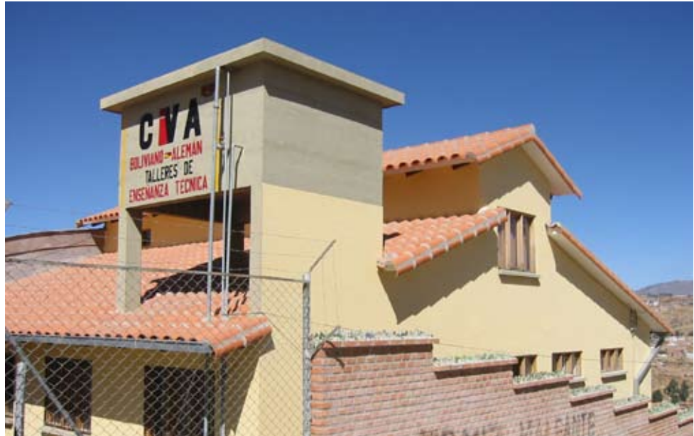
Unterrichtsgebäude der Technischen Werkstätten
