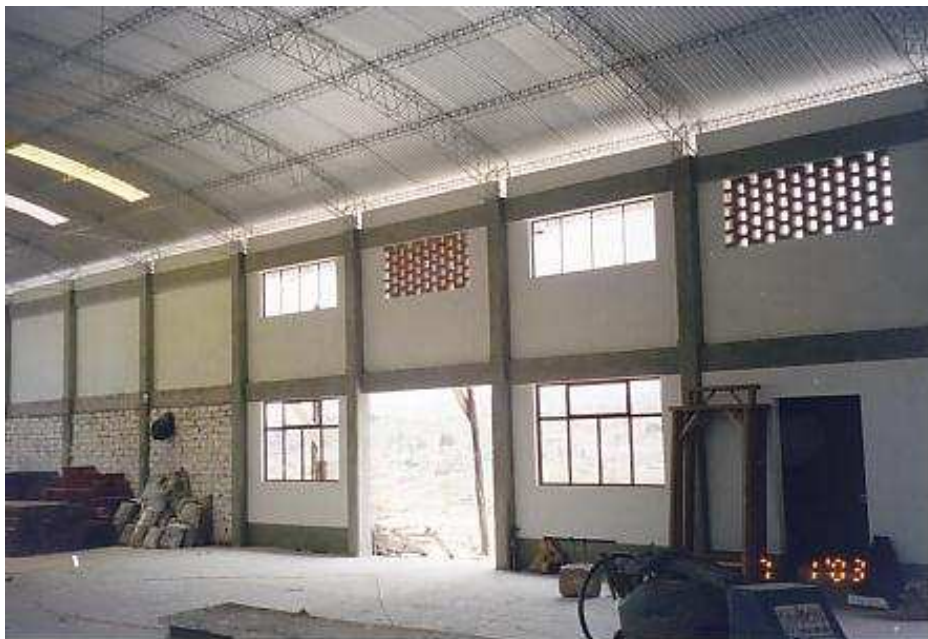
Blick in die Schreinerhalle
