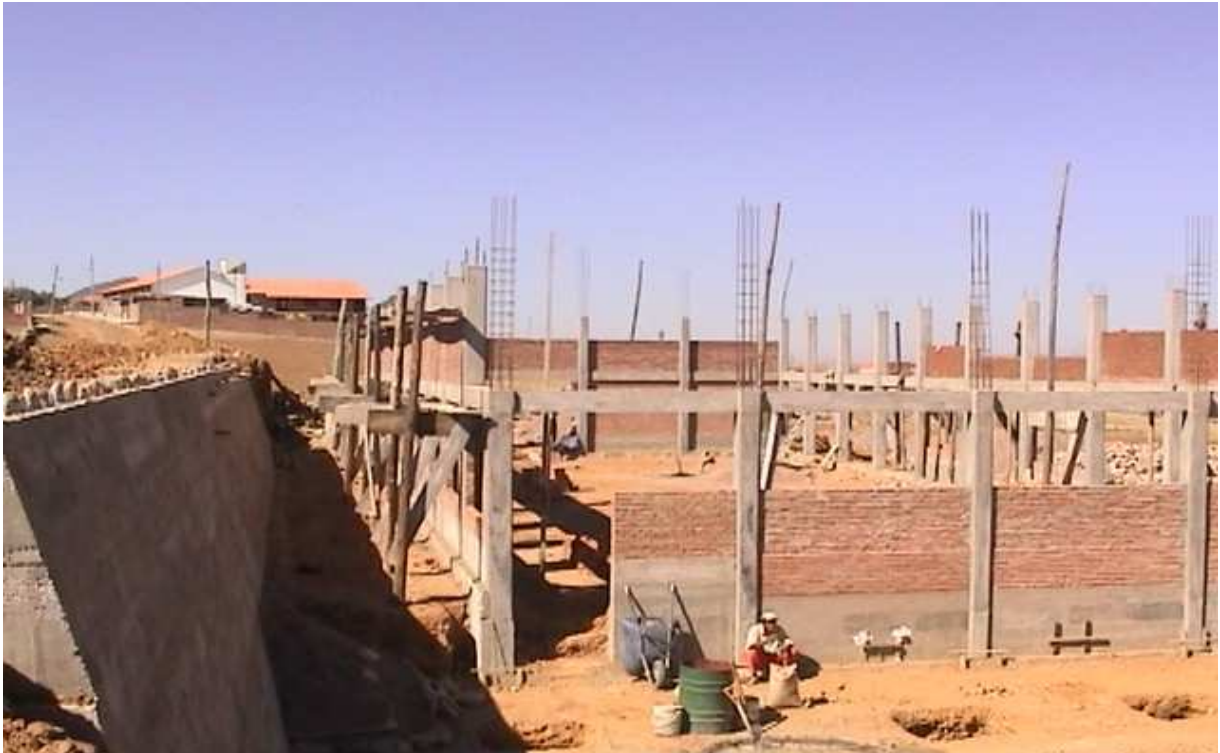
Stützmauer und Rohbau der Schreinerhalle
